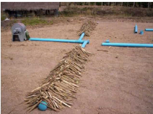
ภาพที่ 4 การประกอบระบบท่ออากาศ
