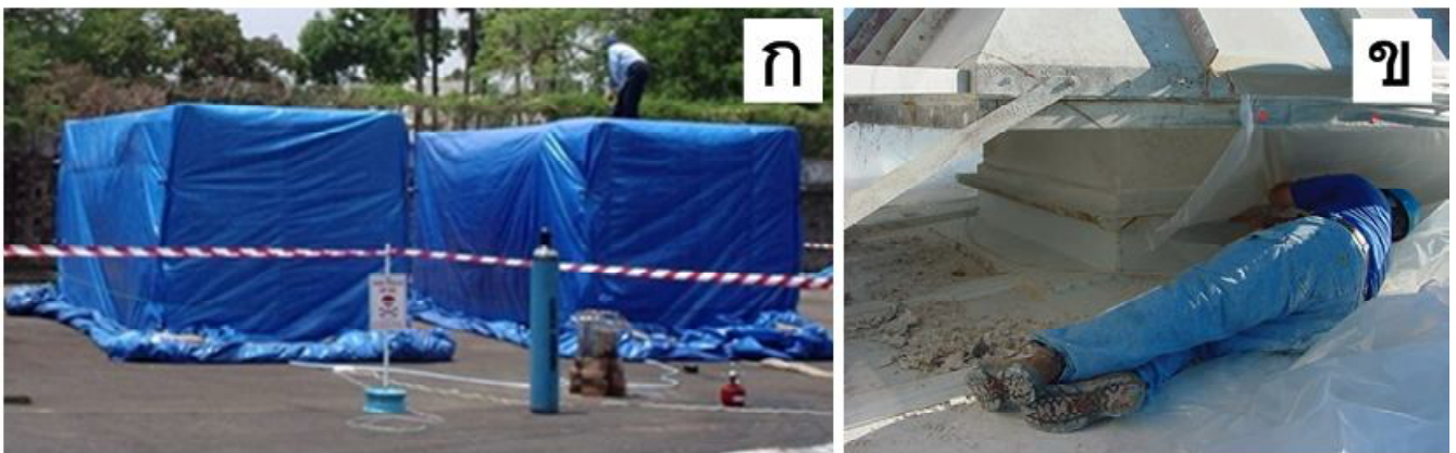
ภาพที่ 1 (ก) การรมยาในตู้คอนเทนเนอร์ และ (ข) การซีลช่องระบายอากาศบนหลังคาของอาคารขนาดใหญ่ ที่มา: (ก) http://www.fumigationindia.com
